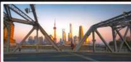
สะพานไวปี้ดู่
