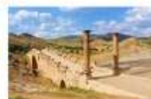
สะพานเซเวอร์วัน
